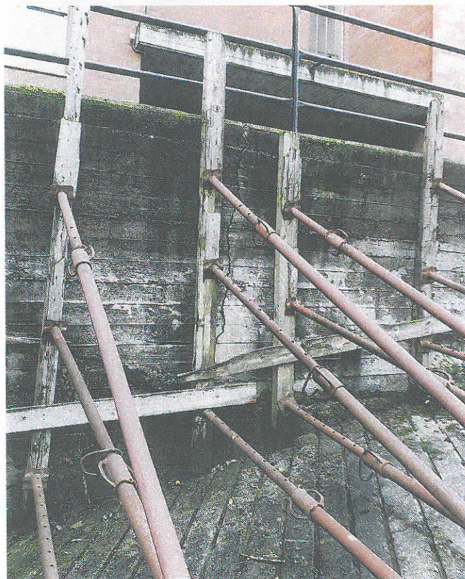
I pali in legno "marci" del muro di sostegno
